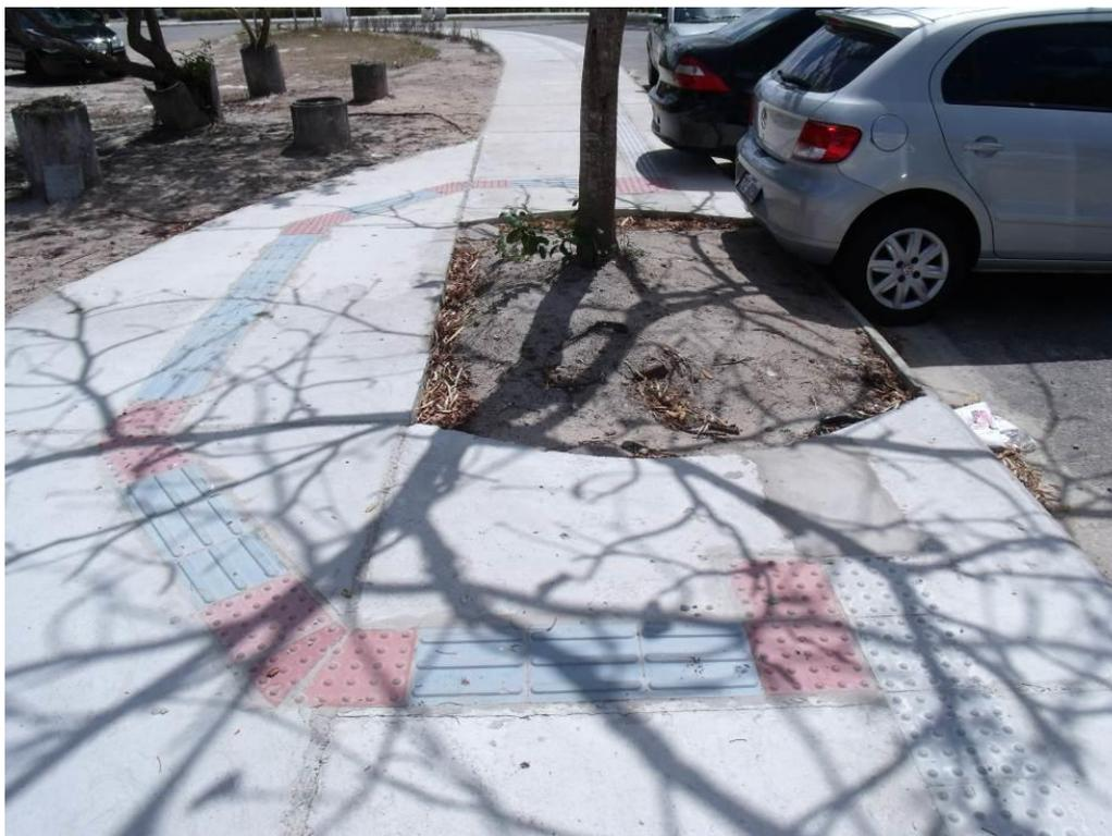
**Figura 24** - Desvio feito com o piso tátil ao redor da árvore, posicionada na calçada próxima à Reitoria.
