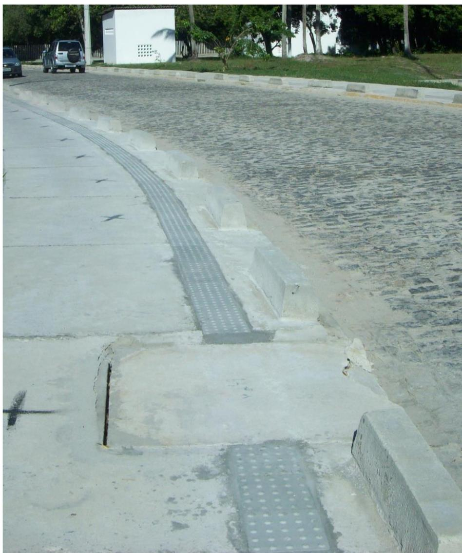
**Figura 6** - Interrupção da colocação de piso tátil nas calçadas próximo a Reitoria, devido à presença de caixas de esgoto. Autoria: Crislayne Lima Santana, em: 04/01/2013.
