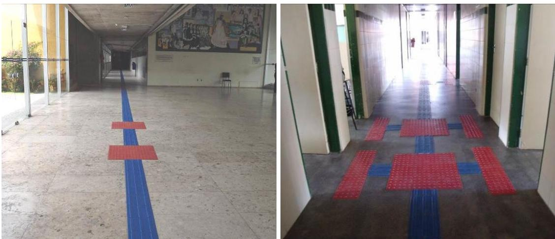
**Figura 22** - Na Reitoria (foto à esquerda) e didáticas (foto à direita) é notável o contraste de cor entre o piso tátil e o adjacente. Autoria: Crislayne Lima Santana, em: 07/01/2013.
