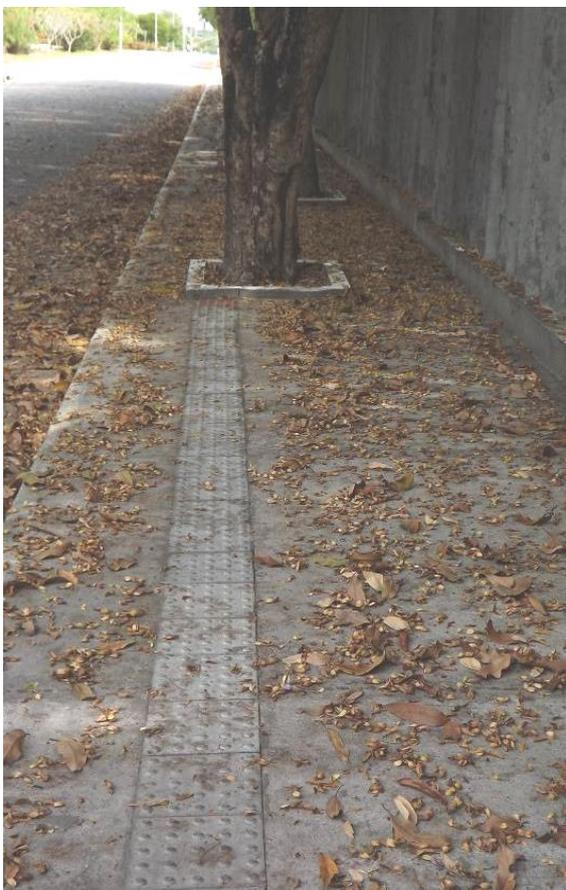
**Figura 7** - Árvore bloqueando a passagem do deficiente visual sem desvio de piso tátil nas calçadas próximas à Reitoria. Autoria: Crislayne Lima Santana, em: 04/01/2013.
