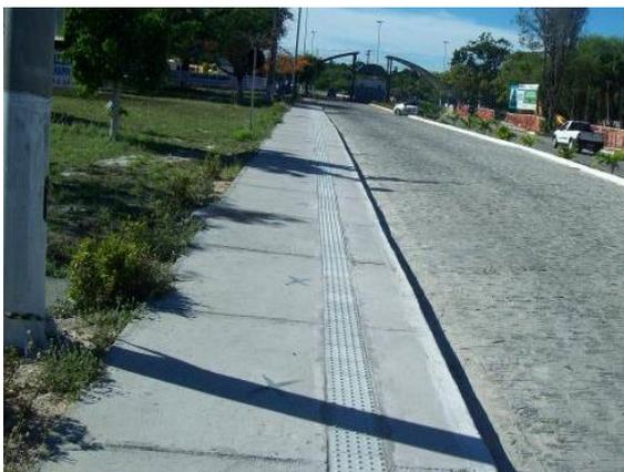
**Figura 20** - Piso tátil colocado na calçada próximo à reitoria, também não apresenta contraste de cor com o piso adjacente. Autoria: Crislayne Lima Santana, em: 07/01/2013.
