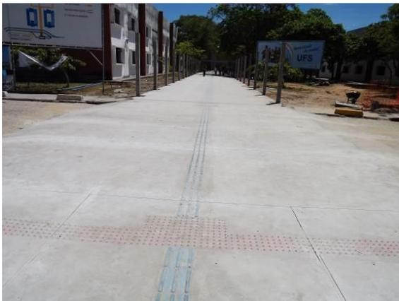
**Figura 19** - Piso tátil colocado na passarela da entrada principal da UFS não apresenta contraste de cor com o piso adjacente. Autoria: Crislayne Lima Santana, em: 07/01/2013.
