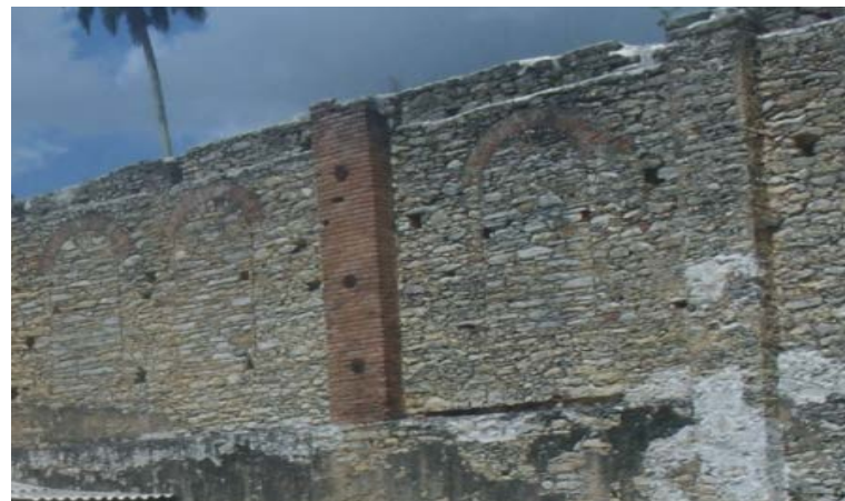
Figura 23 - Pilar em tijolo cerâmico “aparelho à meia vez”. Sítio Ruínas do Teatro.
