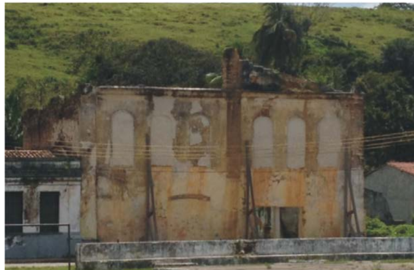
Figura 1- Fachada da edificação do Sítio Ruínas do Teatro.
