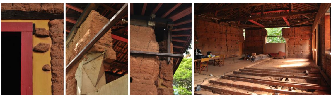
Figura 2: Valor arquitetônico. Tulha. Da esquerda para a direita: Detalhes de incisões em argamassa, suportes de concreto e travamentos em aço, desenhadas em função da estabilização ou consolidação da estrutura em terra; Interior, com destaque para escavações para identificação de fundações. Fotos do autor, 2012.
