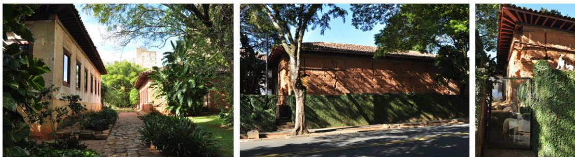
Figura 1: Valor Urbanístico. Casa Grande e Tulha. Da esquerda para direita: Eixo de acesso da Antiga Chácara Paraíso das Campinas Velhas com a Casa Grande à esquerda e a Tulha à direita; Atual visão da Tulha a partir da Avenida Arlindo Joaquim de Lemos, Jardim Proença, Campinas; Acesso público. Fotos do autor, 2012.
